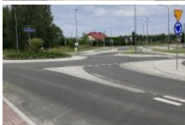
• Przebudowa dróg gminnych
