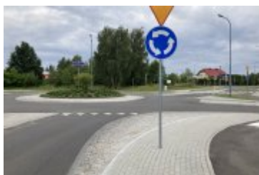
• Przebudowa dróg gminnych
