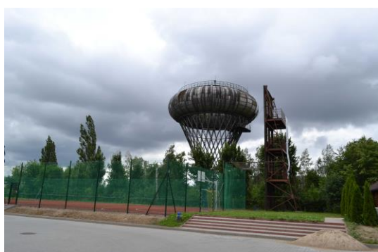
Fot. 11. Wieża ciśnień w Ciechanowie
