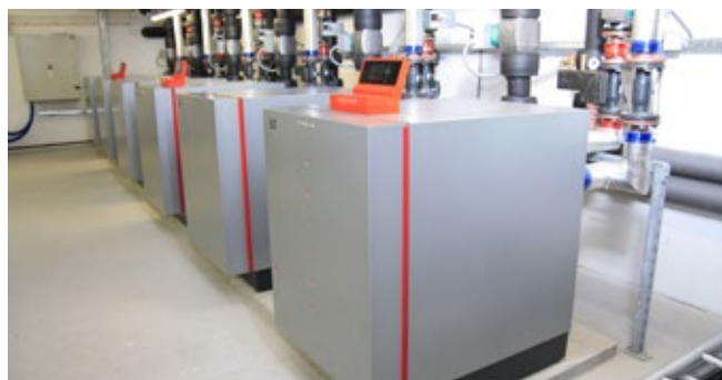
Zdjęcie 39. Pompy ciepła
