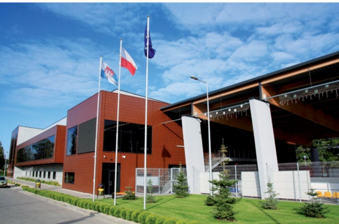
Zdjęcie 37. Budynek AQUARIUM
