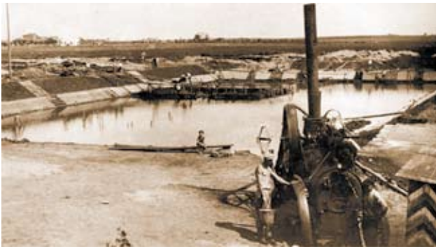
Odkryty miejski basen przy ulicy Targowej podczas budowy w 1935 roku. Fotografia pochodzi ze zbiorów Powiatowej Biblioteki Publicznej.
