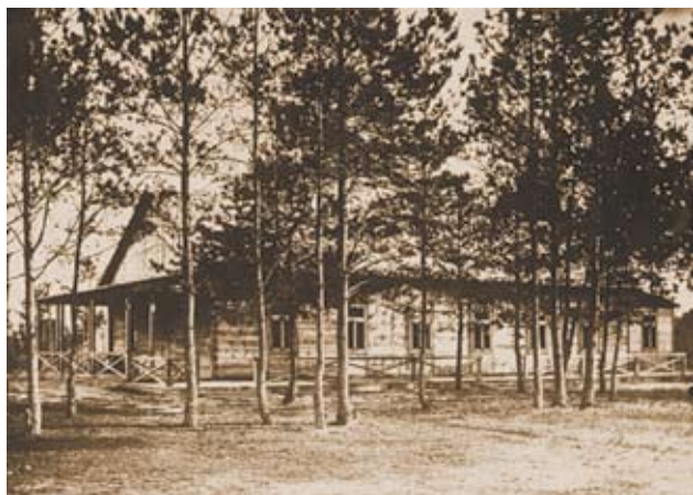
Budynek ośrodka kolonijnego w Ościstowie.
