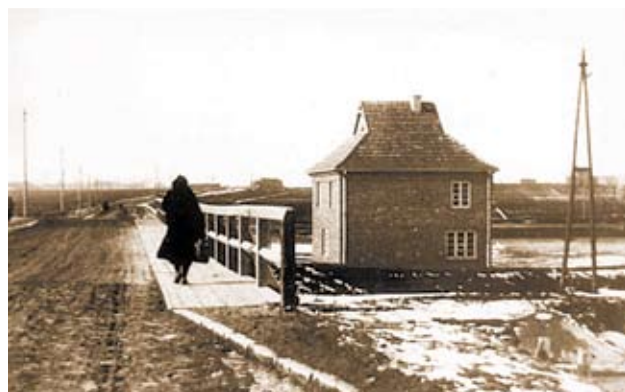
Drewniany most na Łydyni z 1931 r. Po prawej stronie budynek miejskich wodociągów. Fotografia pochodzi ze zbiorów Edwarda Lewandowskiego.
