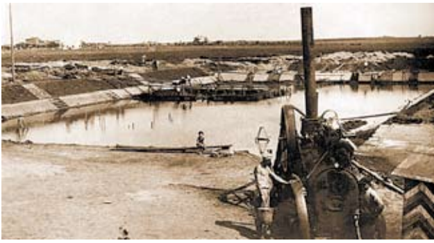
Odkryty miejski basen przy ulicy Targowej podczas budowy w 1935 roku. Fotografia pochodzi ze zbiorów Powiatowej Biblioteki Publicznej.
