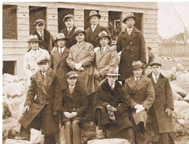
Szkoła Podstawowa Nr 1 w budowie, ul. Orylska, 1932 r., (fot. ze zbiorów Wandy Bąk).
