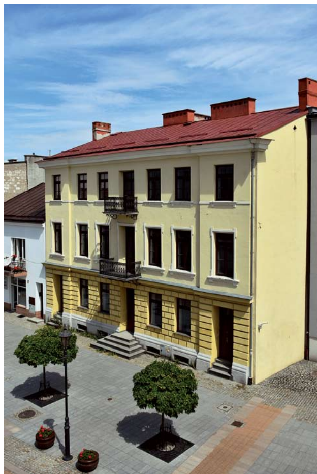
Kamienica Reutta przy ul. Warszawskiej 19, stan obecny, fot. z archiwum Pracowni Dokumentacji Dziejów Miasta.
