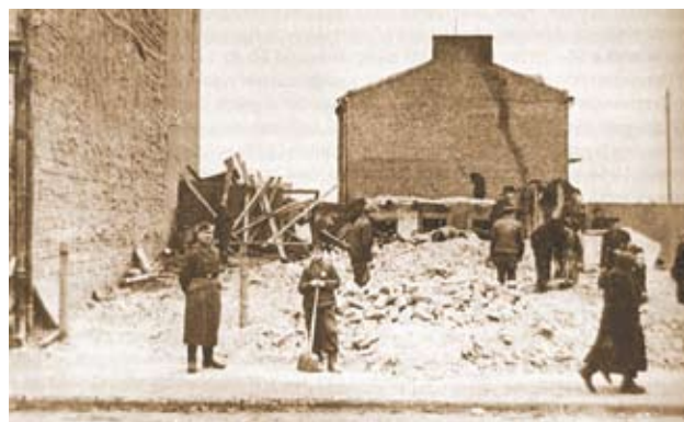
Żydzi przy pracach rozbiórkowych w okupacyjnym Ciechanowie. Źródło: W. Kiefer, Aufbau im Gebiet um Zichenau, Berlin 1945
