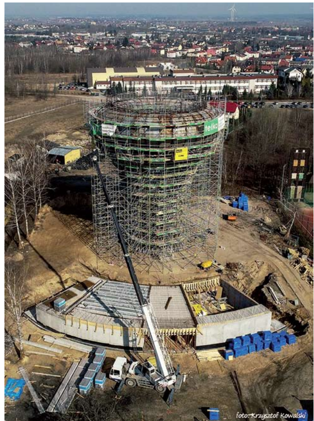
Prace przy wieży, fot. Krzysztof Kowalski
